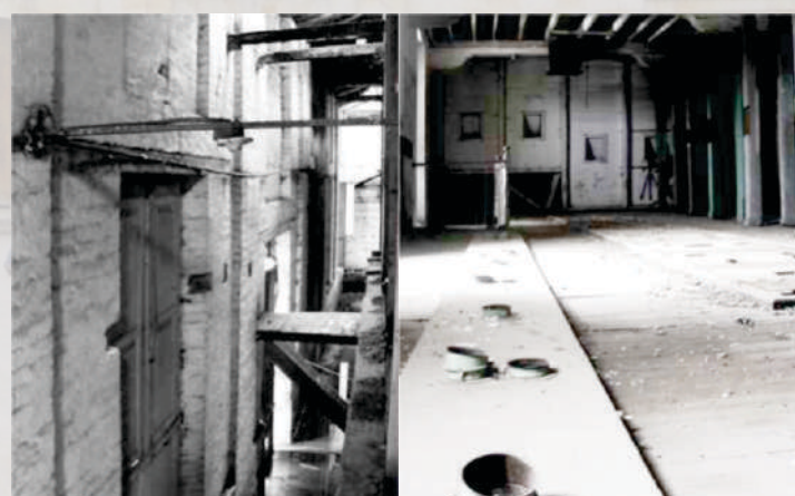
Parte interior del Molino San Carlos 1980.
